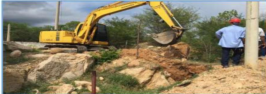
**Registro Fotográfico No. 7** Relleno con maquinaria de material seleccionado de zanjas excavadas
