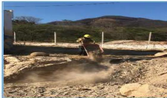
**Registro Fotográfico No. 8** Relleno final con material seleccionado de zanjas excavadas
