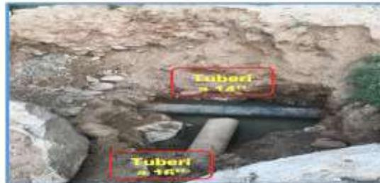
**Registro Fotográfico No. 2** Excavación hasta profundidad de las líneas de flujo objeto del empalme.
