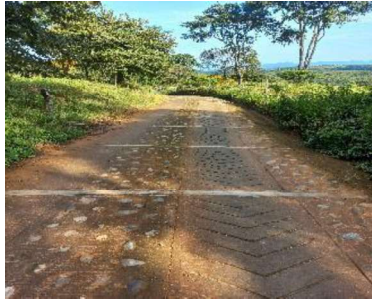
Bordillos y cunetas saturados de vegetación y material de derrumbes de la zona
