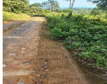
Bordillos y cunetas saturados de vegetación y material de derrumbes de la zona
