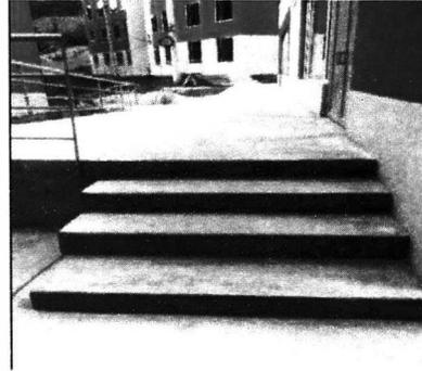
*Fotografía No.4. Escaleras sin pasamanos a ambos lados y Acceso principal con sus rampas laterales superiores al 15%*
