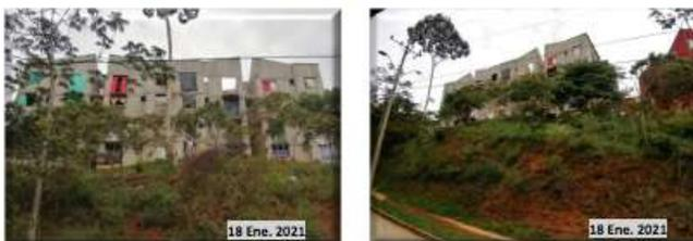
Fachada posterior. Se observa fuga de agua que proviene del talud posterior (humedad sobre el andén).
