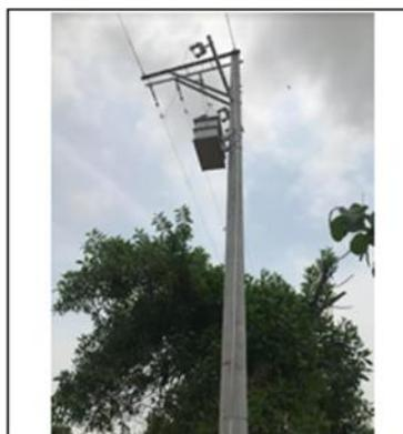
EB INURBE NEMESIO NÁDER: TRANSFORMADOR DE 30 KV NO CONECTADO A LA RED PRINCIPAL
