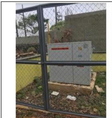
EB PRINCIPAL: EL TRANSFORMADOR DE 230 KVA SE ENCUENTRA SIN CONEXIÓN DE RED DE MEDIA TENSIÓN Y POR TANTO SIN FUNCIONAMIENTO
