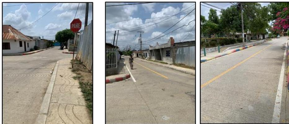
**Imagen No. 9** En el desarrollo de la visita realizada por la CGR, con la Alcaldía de Cereté y personal del MVCT, no se observaron señales de cortes de concreto en la mayoría de las losas del pavimento de los barrios del sector 4 del municipio de Cereté, pese a que en el acta de liquidación se cobran aproximadamente 6.250 ml de cortes de pavimentos.
